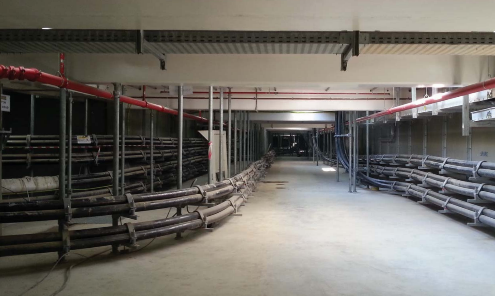
사우디아라비아 초고압 380KV, 800MM 2 XLPE Cable 포설 380KV, 800MM 2 XLPE Cable Pulling, QIPP, Saudi Arabia
