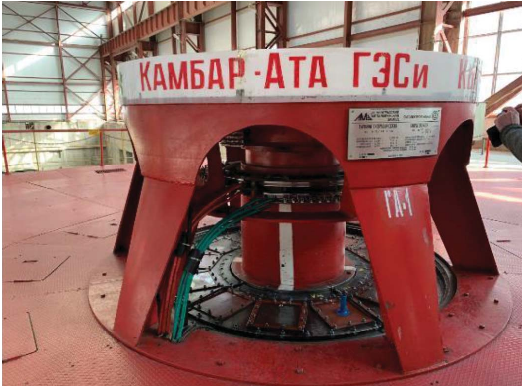
캄바라타 HPP-2-Lot 1, 120MW 수력발전설비 1기 및 부대기기 EPC 공사 Kambarata HPP-2-Lot 1, EPC Construction of 120MW x 1 Unit Turbine, Generator and Balance of Plant
