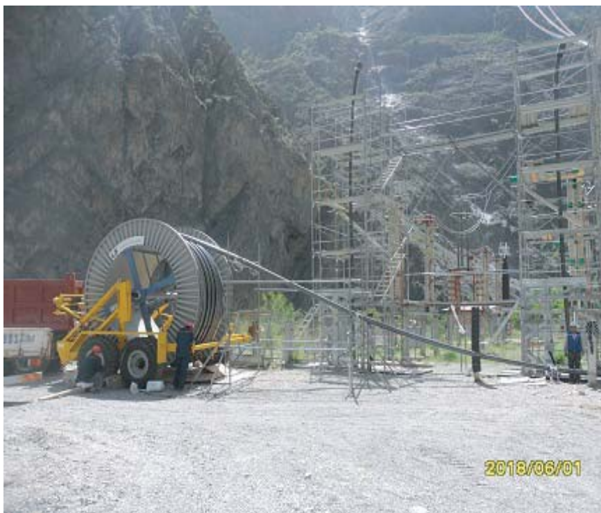
토크토굴 수력발전소 Lot 3 케이블 개선공사 - 500KV, 800 Sqmm XLPE 케이블 포설 Toktogul HPP Lot 3 Cable Rehabilitation - 500KV, 800 Sqmm XLPE Cables Laying
