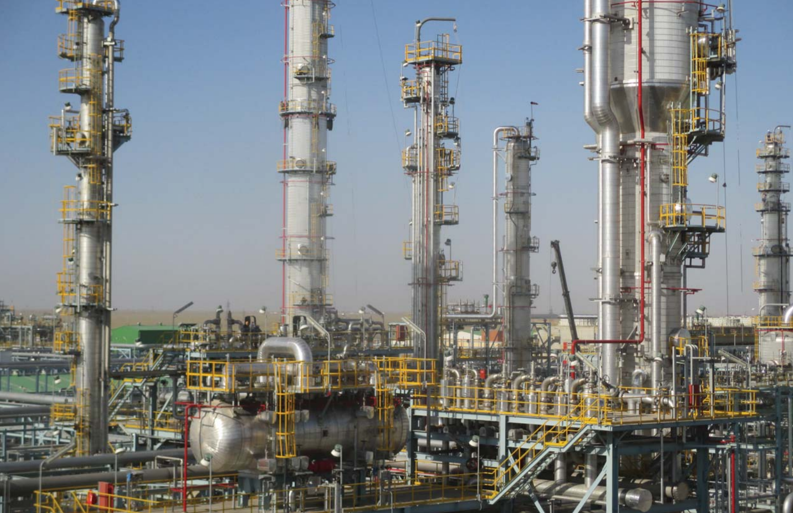
우주베키스탄공화국 UGCC 가스화학단지공사 UGCC GSP Project, Uzbekistan
